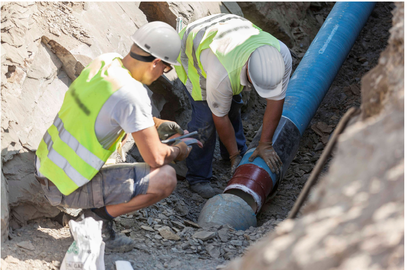
Rohrverlegung/Montage im offenen Rohrgraben
