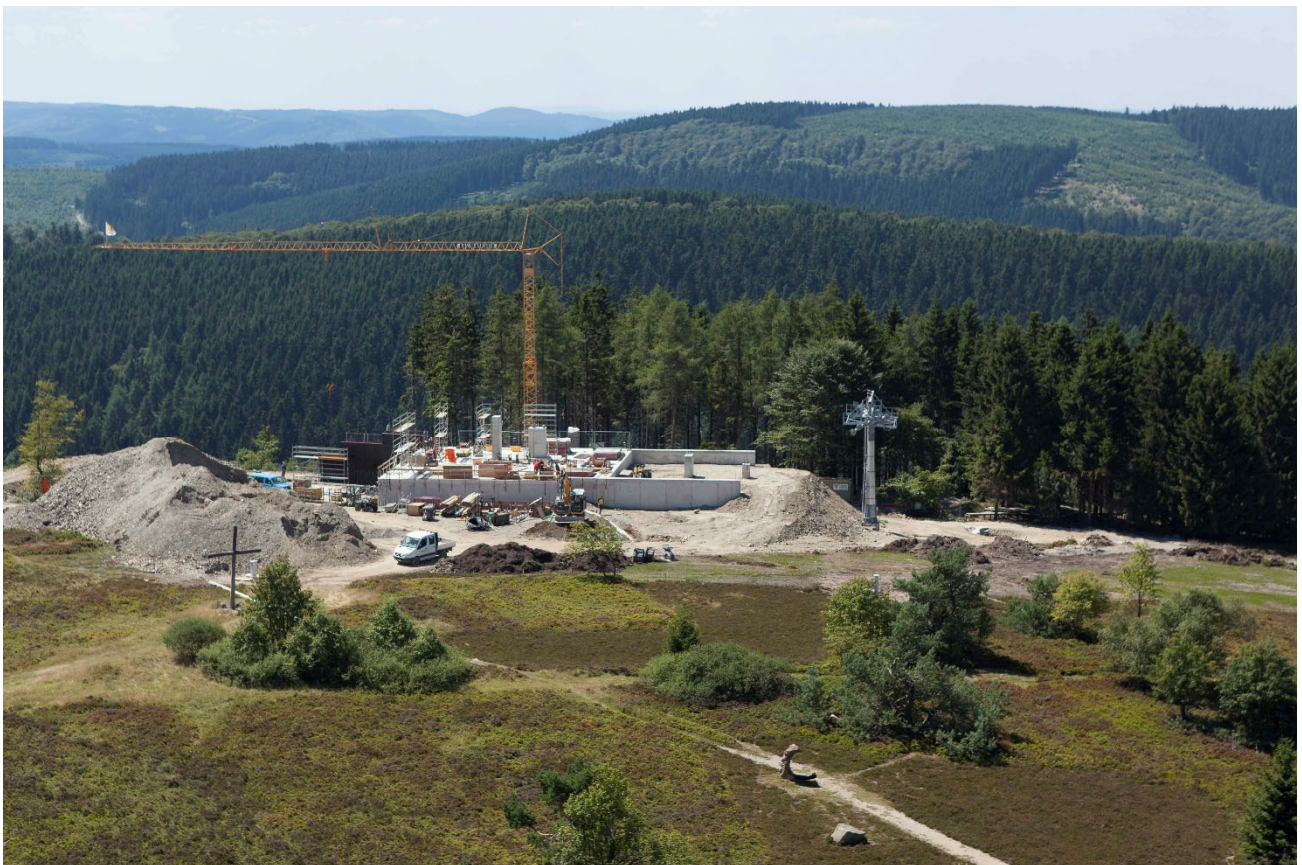
Neuentstehende Bergstation des Lifes
