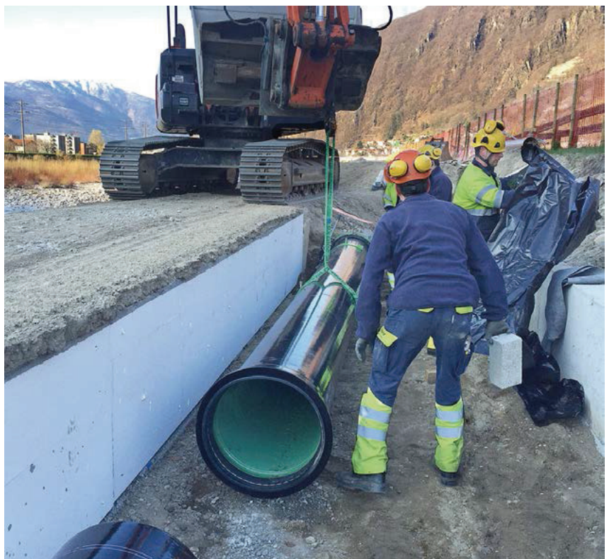
Vollschutzrohre ECOPUR mit elektrisch isolierender Polyurethan(PUR)-Beschichtung
