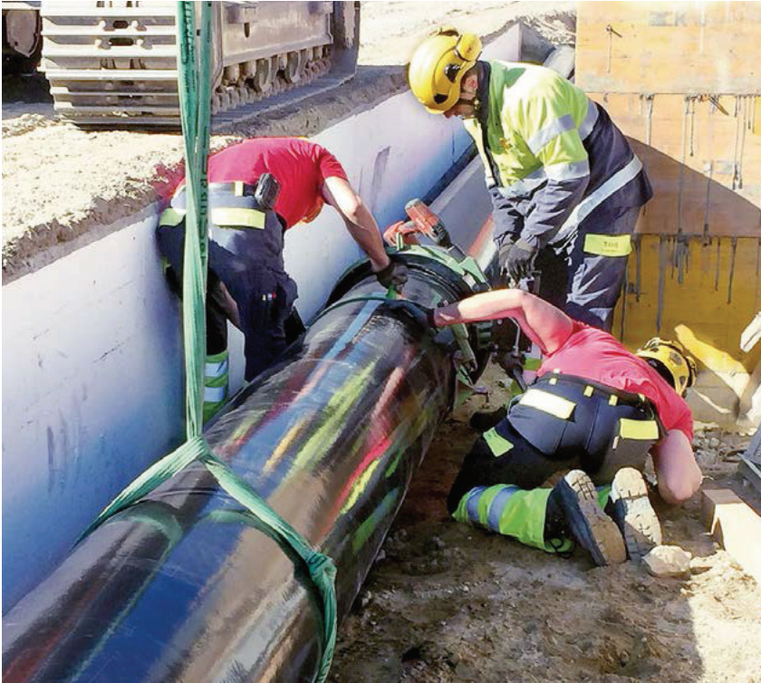
Montage einer längskraftschlüssigen Steckmuffenverbindung HYDROTIGHT
