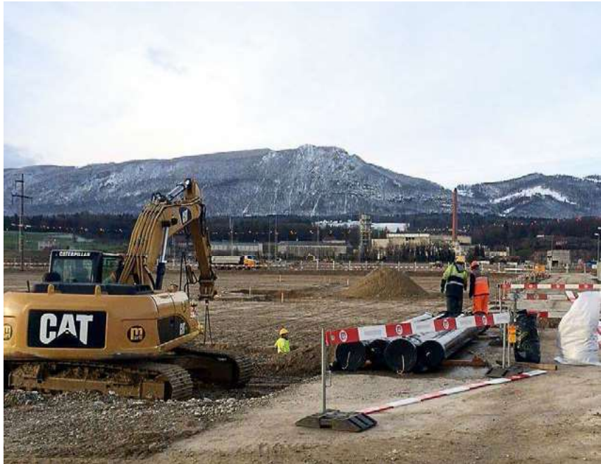
Fig. 1 Blick nordwärts über das Bauareal Biogen Luterbach
