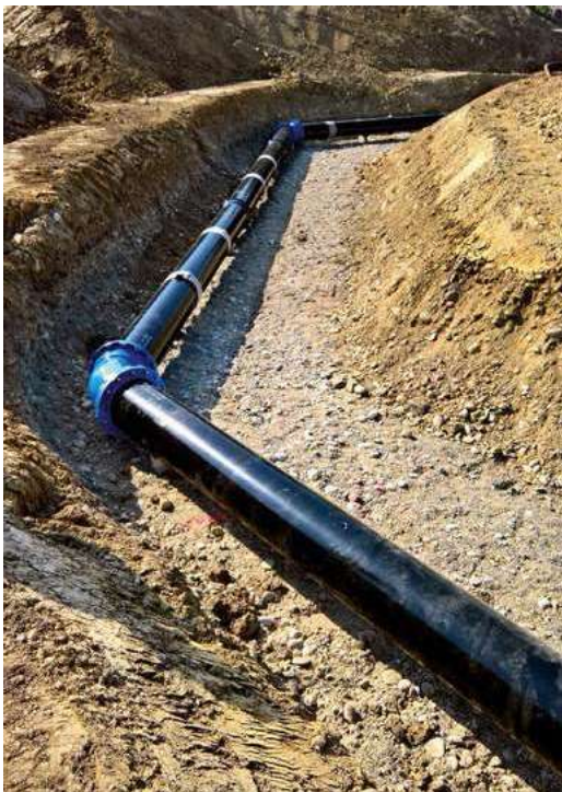
Fig. 4 Umlegung der Transportleitung DN 400 wegen neuem Beton-Kreisverkehr
