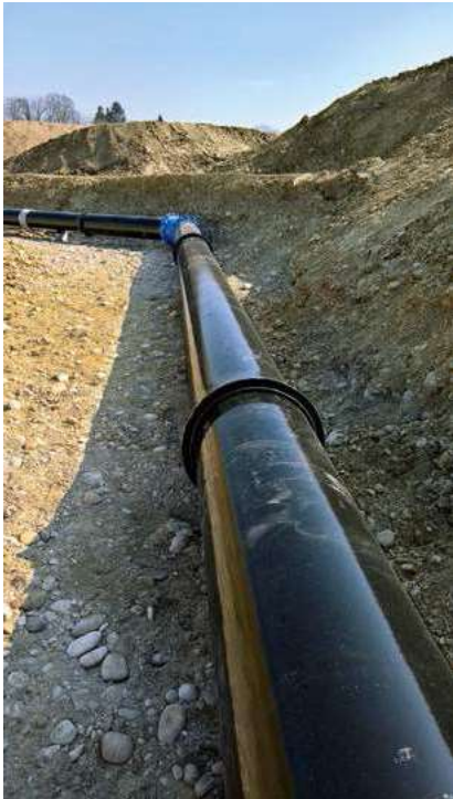
Fig. 5 ECOPUR-Rohr DN 400 mit längskraftschlüssiger Schubsicherung Fig. 2807
