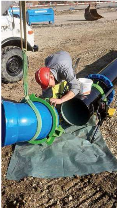
Fig. 6 Vormontage Muffenbogen ECOFIT DN 400 ausserhalb des Grabenprofils mit hydraulischem Verlegegerät
