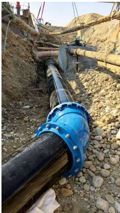
Fig. 8 Muffenbogen DN 400 mit Unterquerung bestehender Werkleitungen
