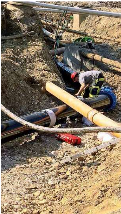
Fig. 7 Erschwerte Montage der neuen Transportleitung DN 400 bei Unterquerung bestehender Werkleitungen
