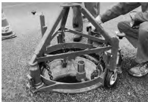
Extraction du cadre à l'aide du système hydraulique
