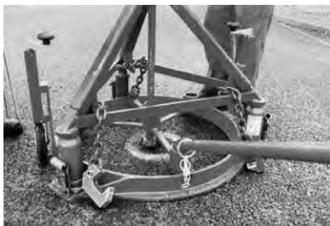
Extraction du couvercle, découpage du revêtement
