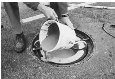
Poser le coffrage gonflable, fig. 3280, remplir de béton de remplissage Addiment (art. 21006163)
