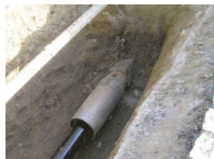
Corpo ad espansione e procedimento a squarcio
