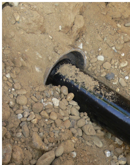
Introduzione con ECOPUR tubo a protezione integrale
