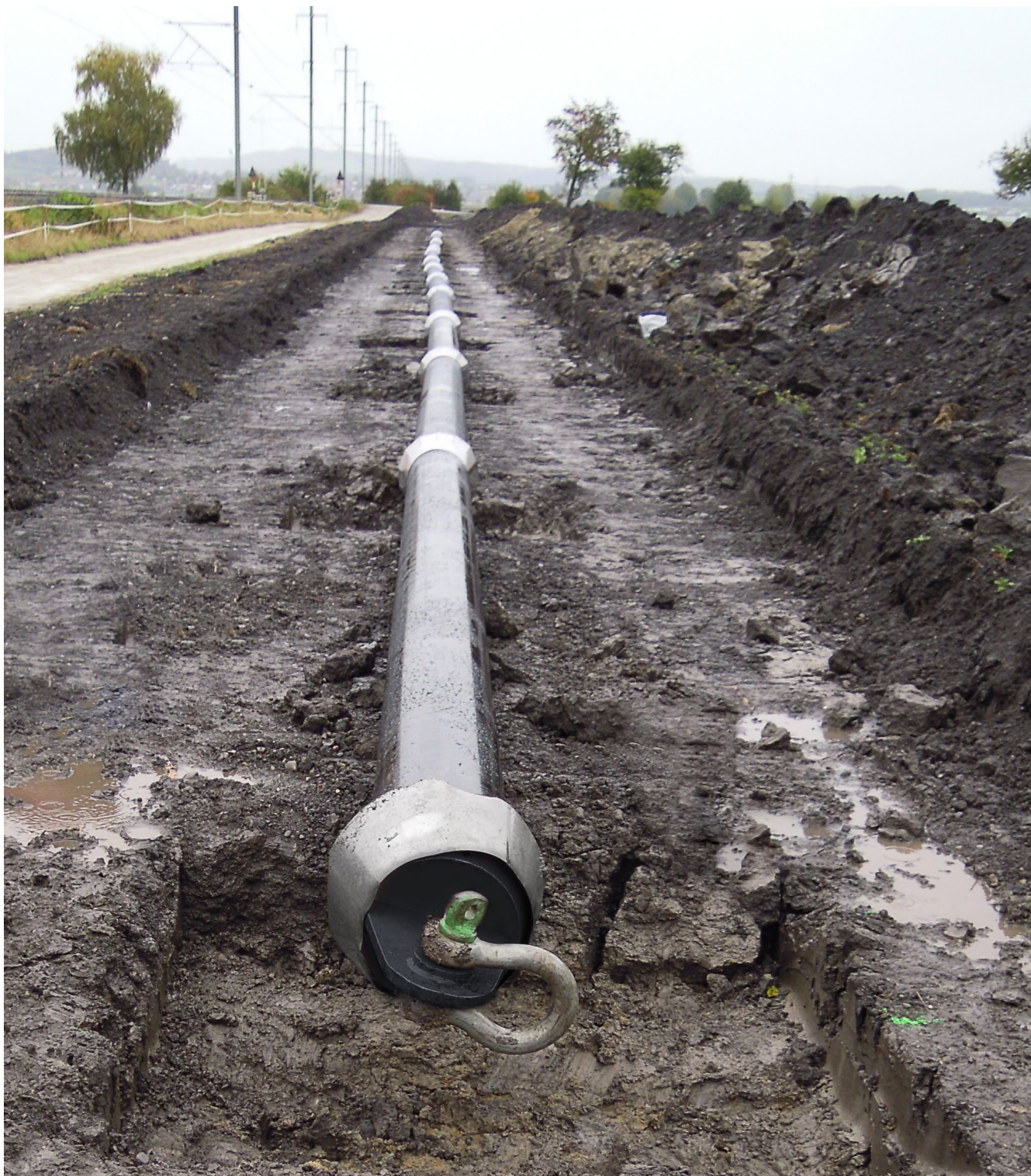
Tratto di condotta premontato
