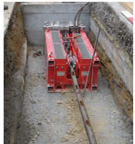
Incastellatura di trazione installata
