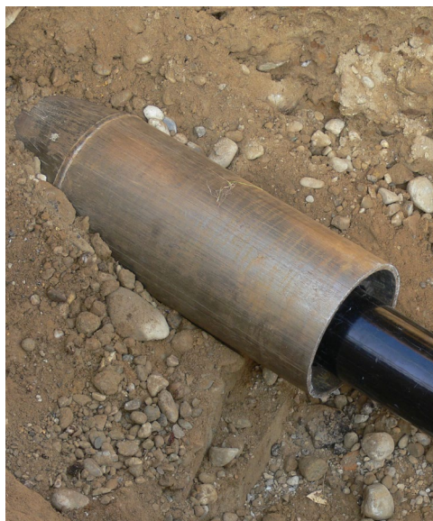
Introduzione con ECOPUR tubo a protezione integrale
