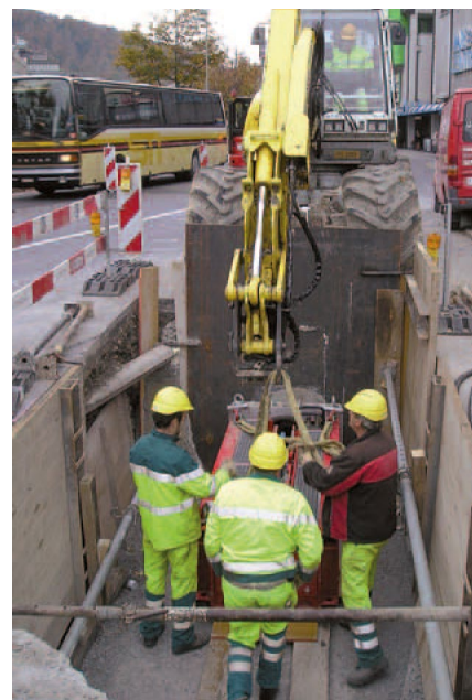
Installazione dell'incastellatura di trazione
