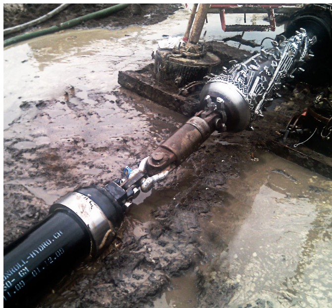
Tête de tirage du train de tuyaux dans la cellule d'arrivée
