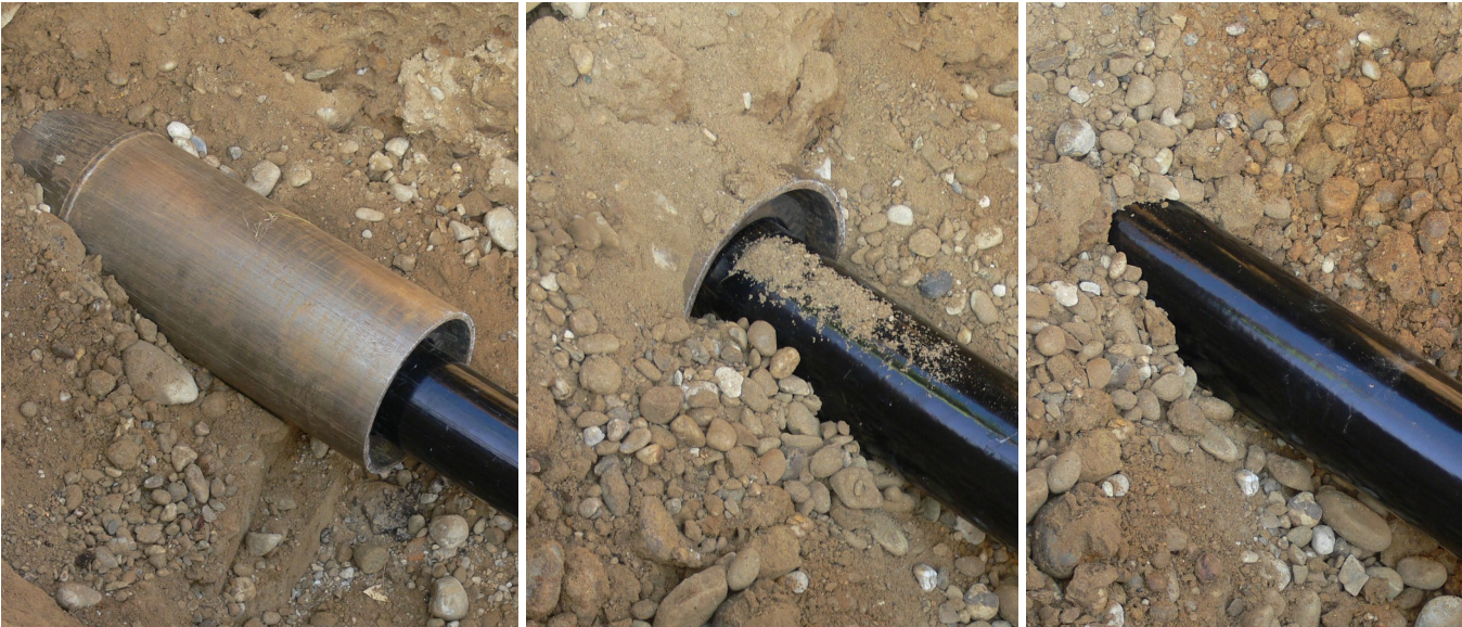
Pose par éclatement: calibrage du trou de passage et tirage des nouveaux tuyaux à protection intégrale ECOPUR
