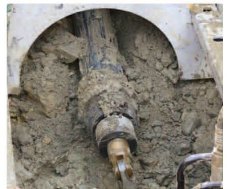
Con éxito en la zanja final
