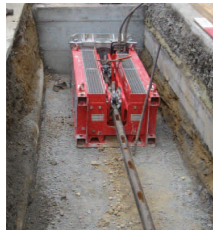
Deslizador de tracción instalada
