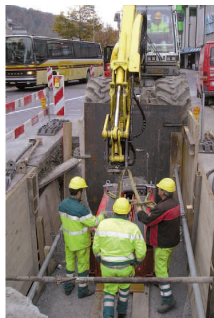
Instalación de la deslizadera de tracción
