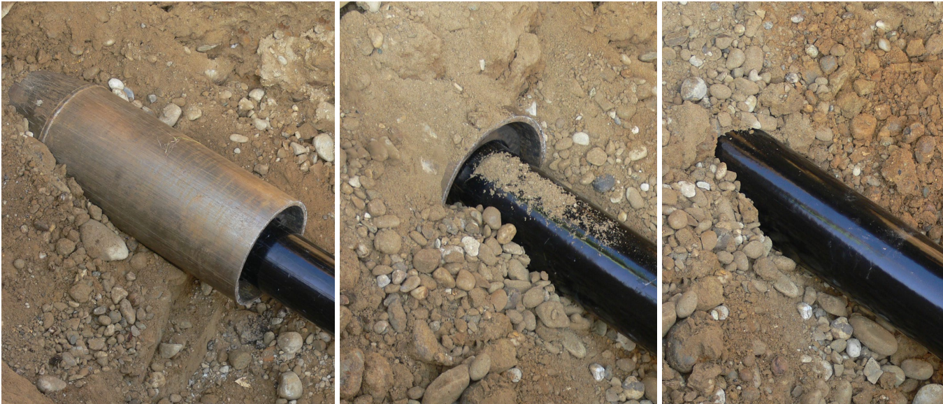
Einzug Vollschutzrohre ECOPUR
