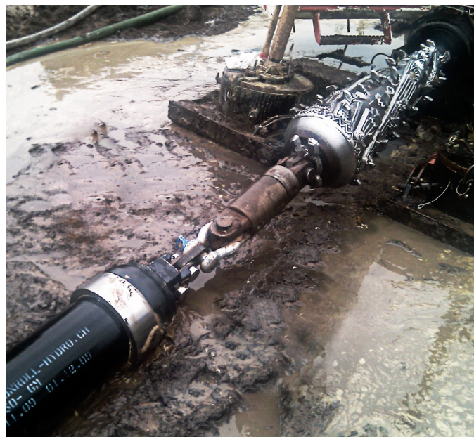
Aufweit- und Zugkopf nach dem Rohreinzug
