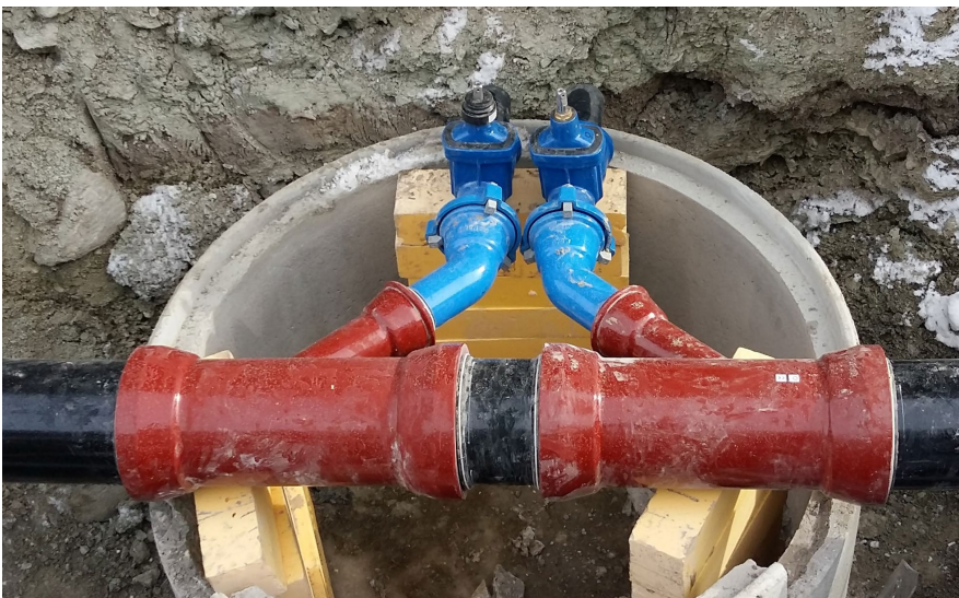
ECOPUR DN 250 con sistema di tenuta stagna DN 100 per scambiatori di calore
