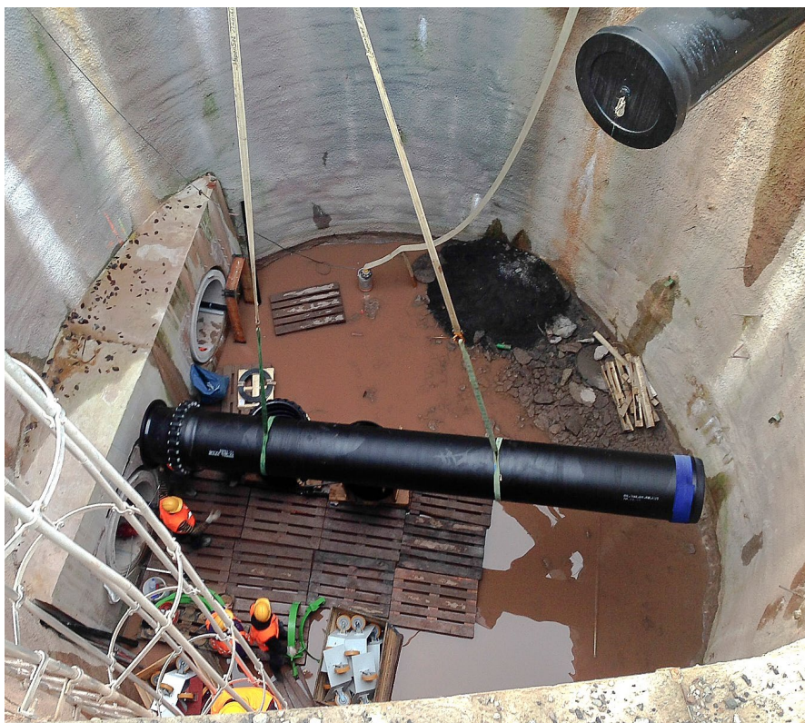
Conduite double DUCPUR DN 700 dans le puits, arrivée dans le microtunnel en béton
