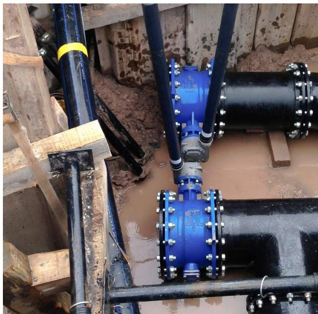
Sorties latérales avec vannes papillon DN 400
