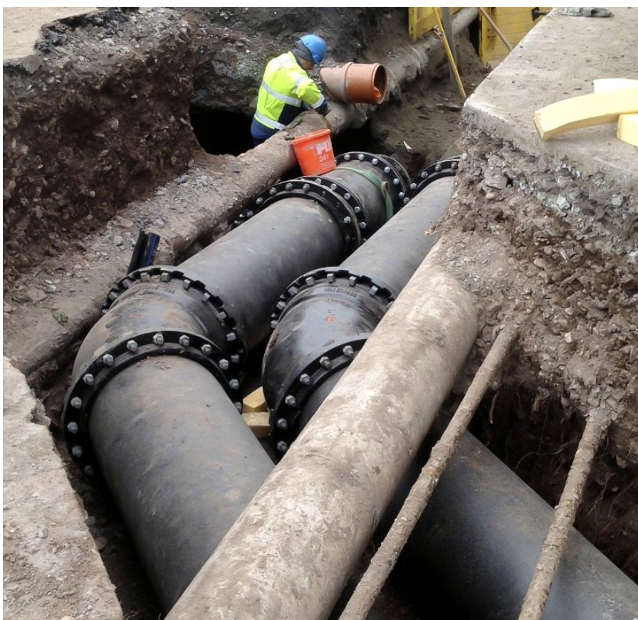
vonRoll DUCPUR, conduite double aller et retour
