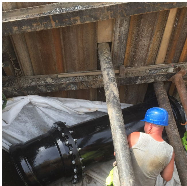
Montage DN 600 ECOPUR en fouille étayée
