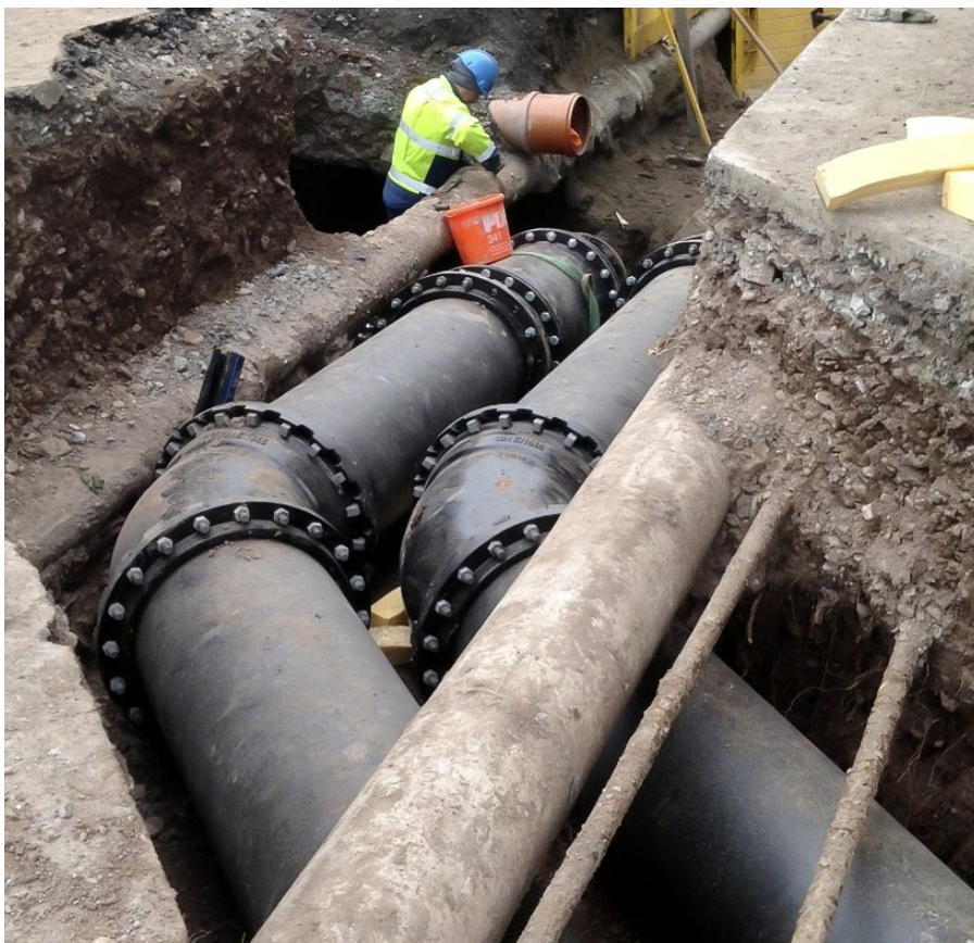
vonRoll DUCPUR, doble conducto para el suministro y el retorno
