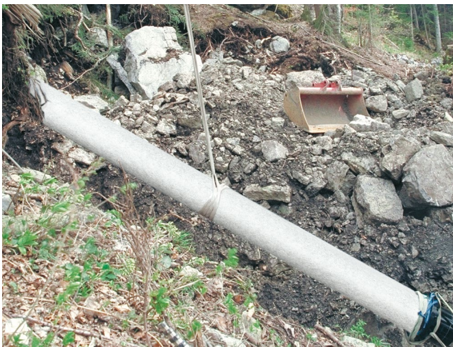
Posa in ambiente roccioso
