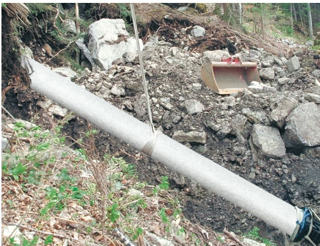
Protección frente a desprendimientos
